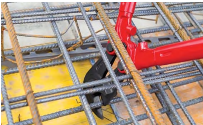
Особая форма головки ножниц для резки арматурной сетки 71 82 950 позволяет резать плотно прилегающую арматуру
