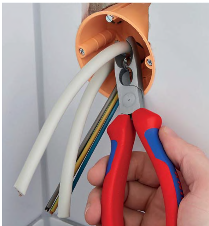
Удаление оболочки с проводов в глубине монтажной коробки для скрытой проводки
